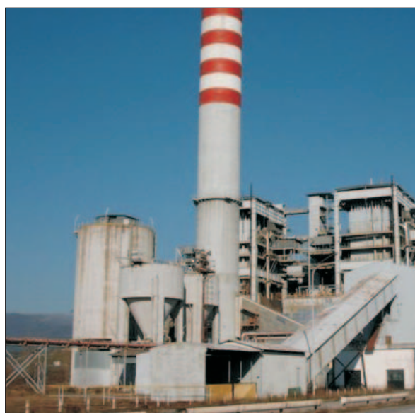
La Centrale del Mercure
